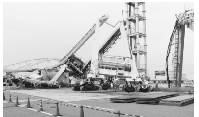
夢洲コンテナターミナルで倒壊したRTG
